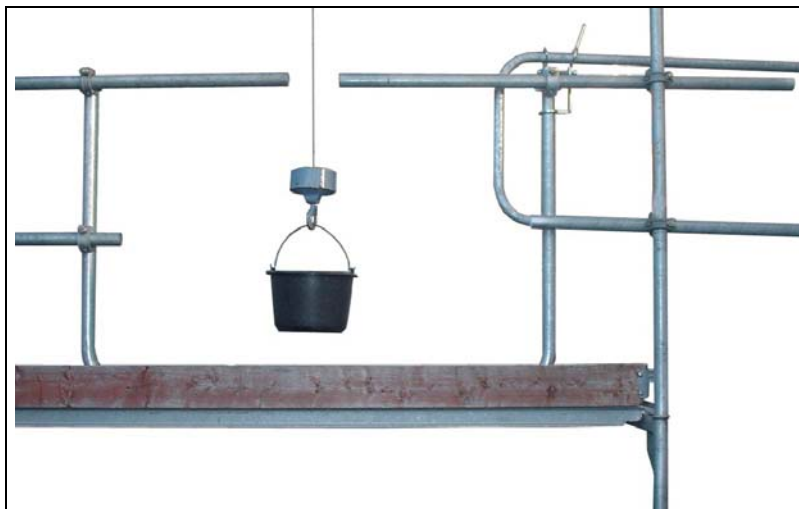
Obr. 6 Zajištění místa nakládání a vykládání
